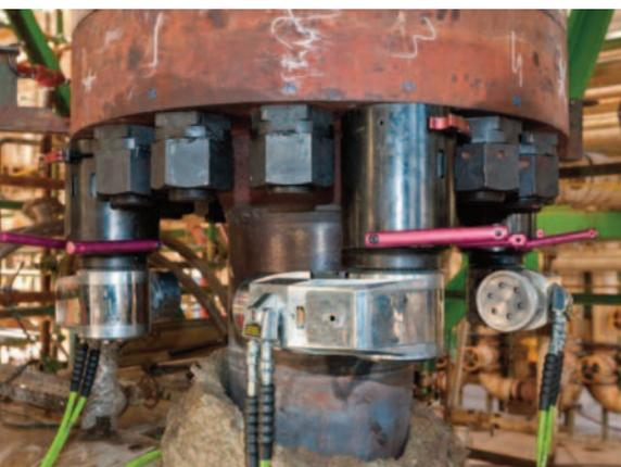
**▲** Рисунок 9. Работа в системе Simultorc моментом-натяжением с помощью шайбы HYTORC и опорного стакана.
