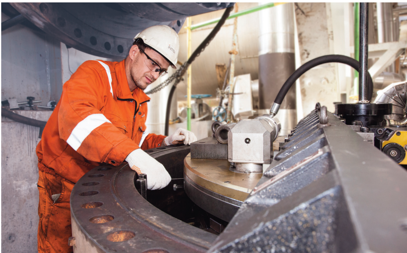
Протачивание уплотнительных поверхностей
