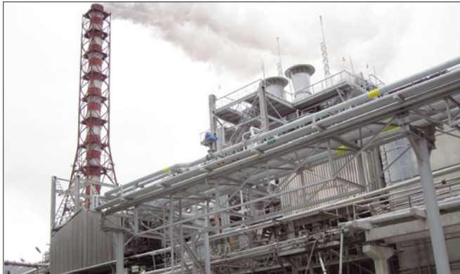
Рис. 3. Аппарат захлаживания воздуха, совмещенный с установкой испарения аммиака для производства фосфорных удобрений
