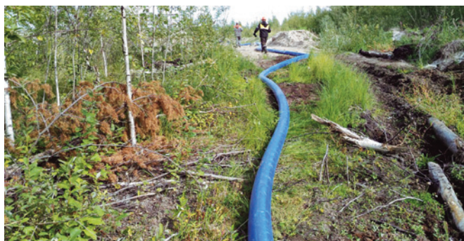
Рис. 1. Осмотр мобильного трубопровода
