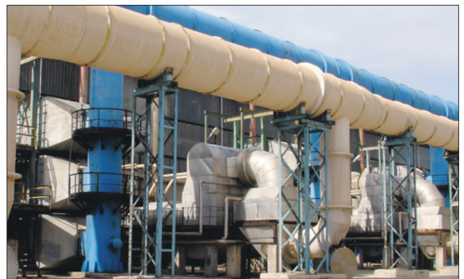
Рис. 5. Производство слабой азотной кислоты на базе агрегатов УКЛ-7
