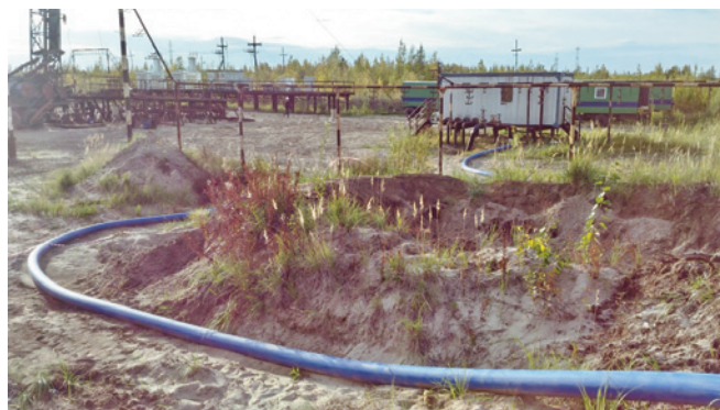
Рис. 5. Подключение мобильного трубопровода к АГЗУ
