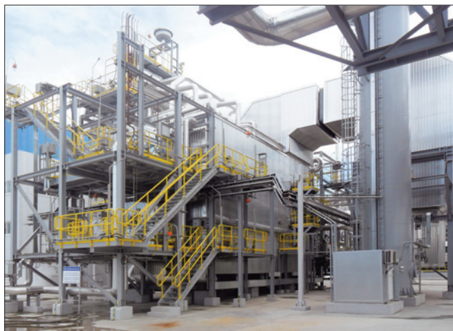
Рис. 4. Вспомогательный котел агрегата аммиака
