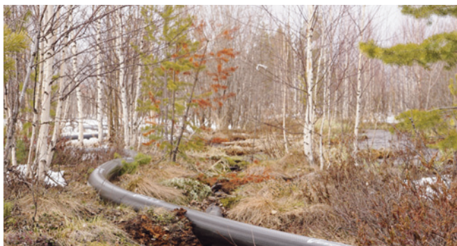
Рис. 4. Прокладка мобильного трубопровода по болоту
