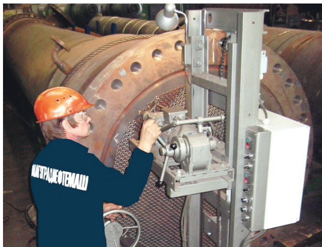
Рис. 3. Установка для торцевания и высверливания труб МЭТ-2 в работе
