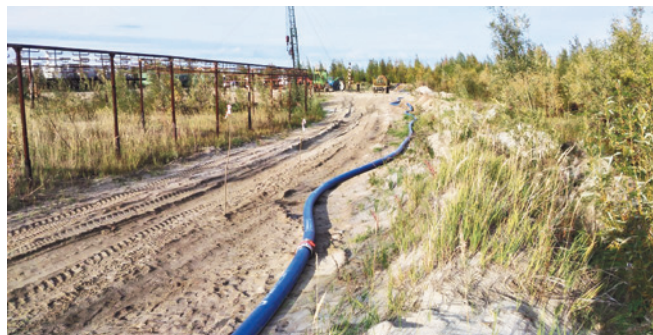
Рис. 2. Ввод скважины в эксплуатацию при помощи мобильной трубопроводной системы
