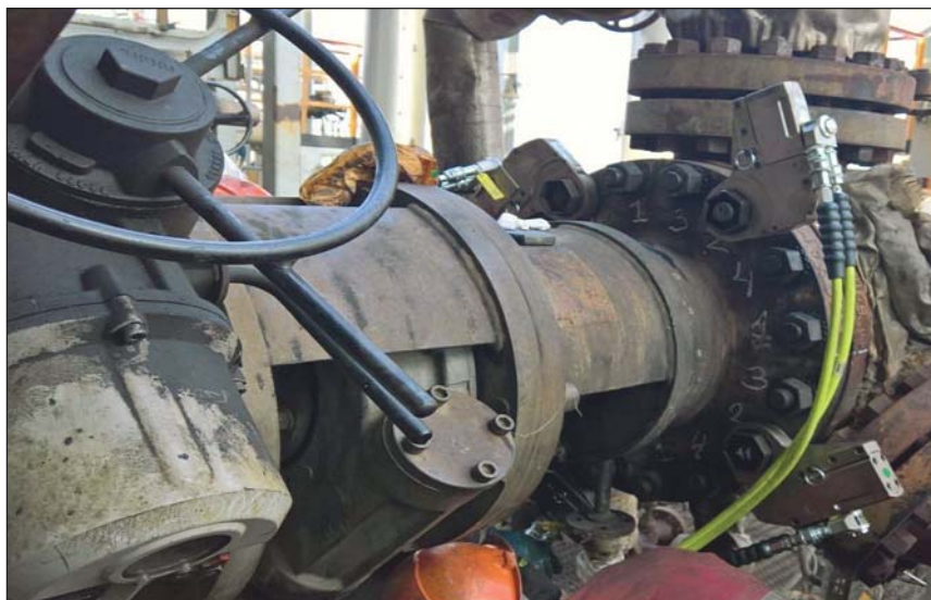
Рис. 2. Пример применения опорных шлицевых шайб на Волгоградском НПЗ
