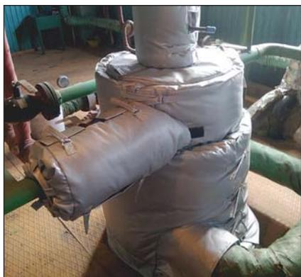
Рис. 1. Оборудование в термочехле
