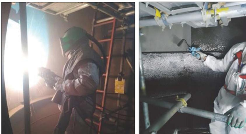
**Рис. 7.** Процесс нанесения металлического покрытия на внутреннюю поверхность аминового абсорбера
