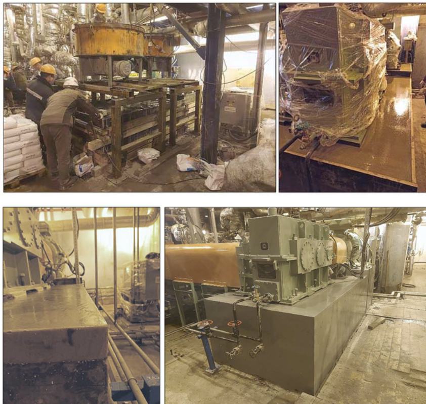
Процесс изготовления фундаментов
