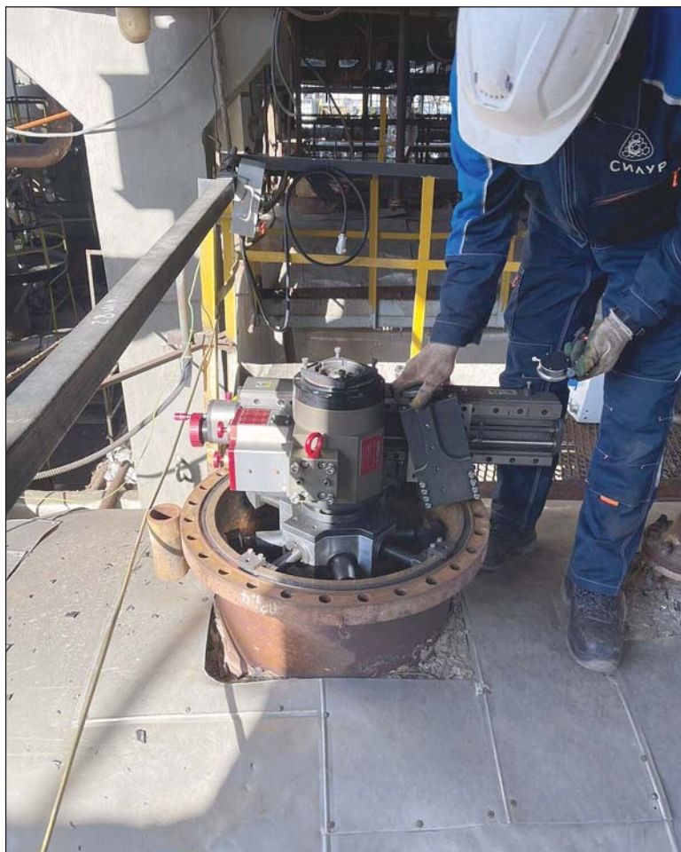
Расточка уплотнительных поверхностей мобильными портативными станками
