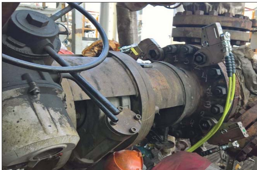
Рис. 11. Пример применения опорных шлицевых шайб на Волгоградском НПЗ
