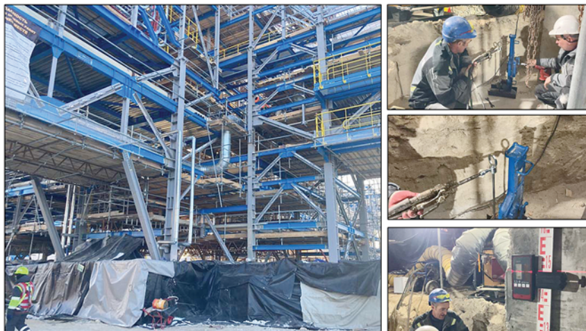
Процесс организации работ, сооружение тепляков и непосредственно зачка материала
