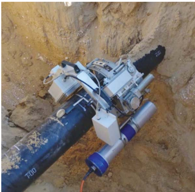
Рис. 5. Работа в траншеях
