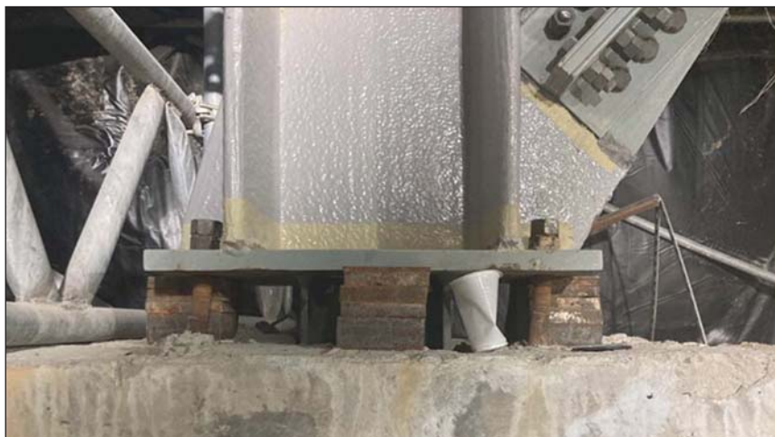
Остановка просадки конструкции
